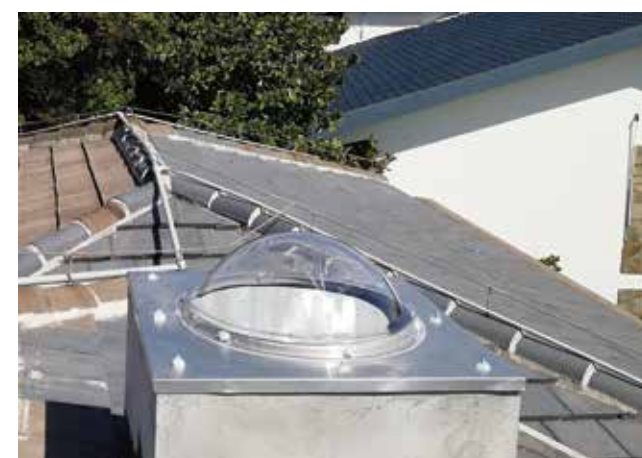
▲ 天瑞自然光导光系统B系列产品安装实例
